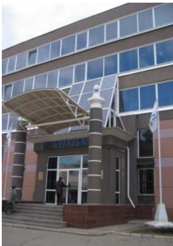
Центральный офис ОАО КБ «Севергазбанк»
